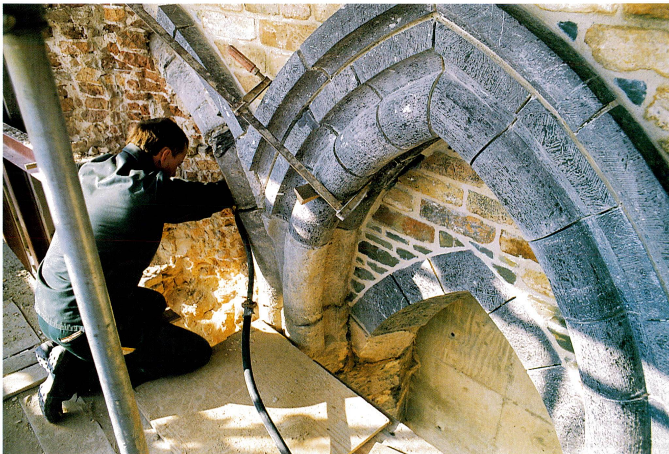
Een deel van de 13de-eeuwse arcaden aan de zuidwand van de Sint-Salvatorstoren tijdens de restauratie, voorjaar 1996. De rechter boog is al gerestaureerd, de linkse wordt vrijgemaakt.
